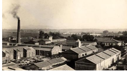
繊維 大和紡績高田工場 (1896 年)
