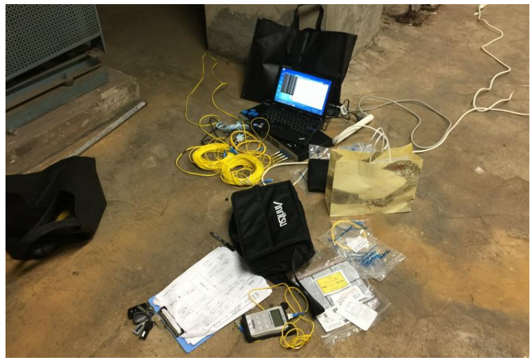
素人 ファイバー 接続工事
