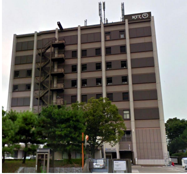
NTT 東日本 つくばビル (素晴らしい 聖地) 筑波大学もこのビルの配下
