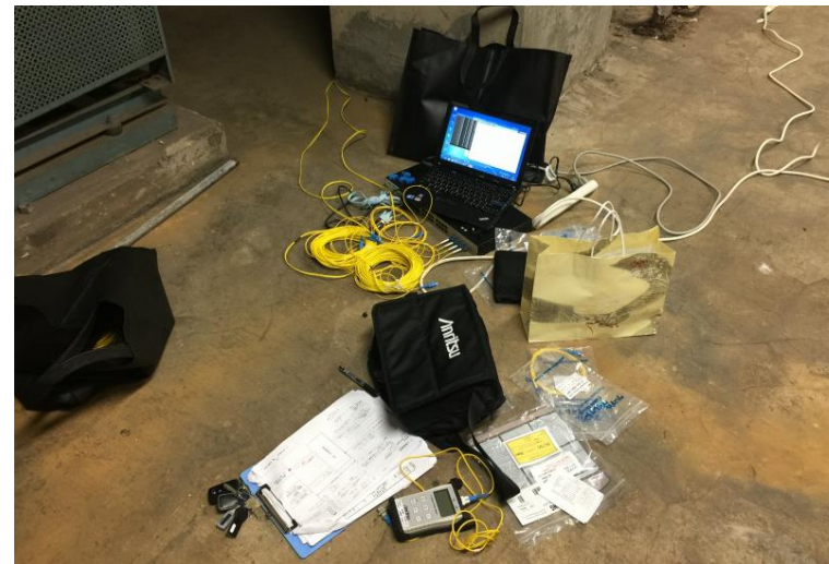
素人 ファイバー 接続工事
