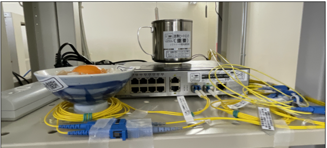
PPPoE 網終端装置と接続されている ISP 側の通信装置設置用棚 (ソフトイーサ株式会社提供)
