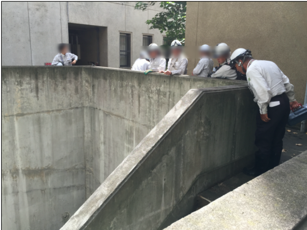
筑波大学の地下共同溝を通じて、学情センターに、著者がオーダした NTT 東の ありがたい 40 芯の新しい NTT 東日本光ファイバを引いていただく様子。
