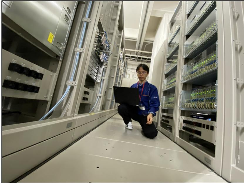
収容ルータにシリアルケーブルで Config を挿入する社員の写真 (模擬) しかし、装置は膨大に存在する (全国に数千台) ので、この方法ではきりががない
