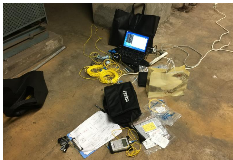
素人 ファイバー 接続工事
