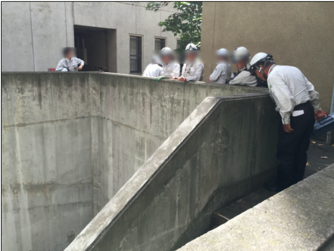
筑波大学の地下共同溝を通じて、学情センターに、著者がオーダーした NTT 東の ありがたい 40 芯の新しい NTT 東日本光ファイバを引いていただく様子。
