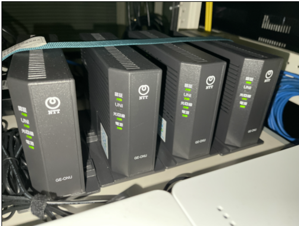
フレッツの GE-PON ONU (宅内装置)。 写真は、筑波大学学情センターに立ち並ぶ大量の ONU
