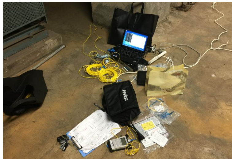
素人 ファイバー 接続工事
