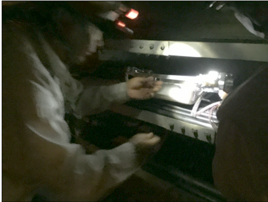
筑波大学の地下共同溝の奥深くでの光ファイバ同士の融着接続の瞬間
