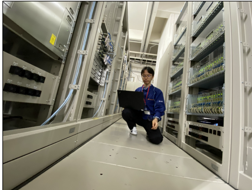
収容ルータにシリアルケーブルで Config を挿入する社員の写真 (模擬) しかし、装置は膨大に存在する (全国に数千台) ので、この方法ではきりが無い
