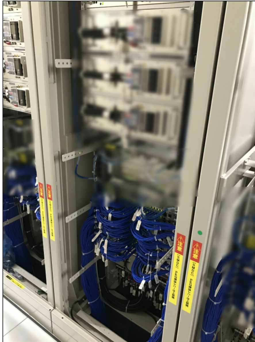
複数台の GE-PON OLT から大量に LAN ケーブルが集まる集線スイッチ。 1 本の青い LAN ケーブルに最大 32 世帯分が VLAN で重畳されて歓迎される
