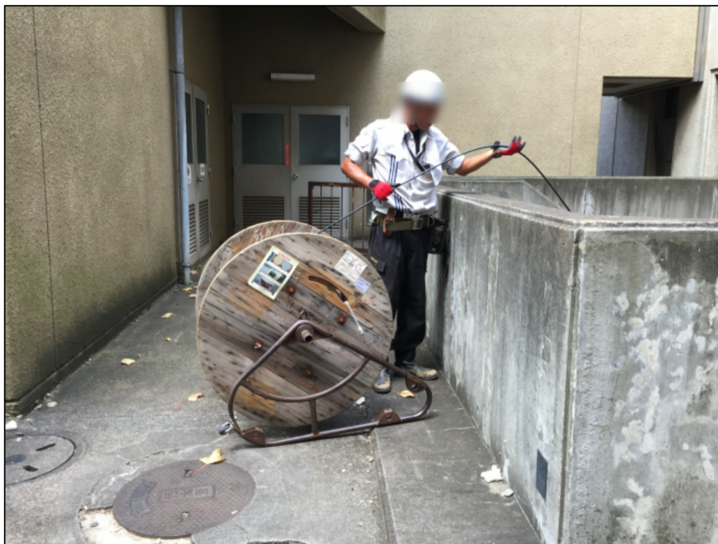
筑波大学の地下共同溝に光ファイバを注入するための樽
