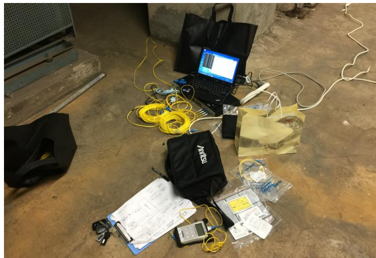
素人 ファイバー 接続工事
