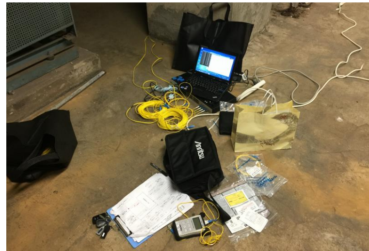
素人 ファイバー 接続工事
