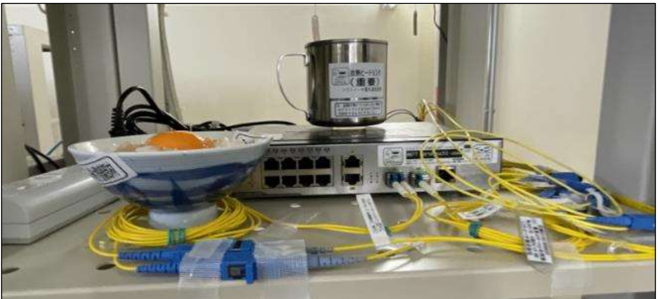
PPPoE 網終端装置と接続されている ISP 側の通信装置設置用棚 (ソフトイーサ株式会社提供)
