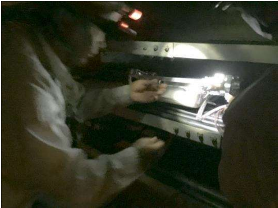
筑波大学の地下共同溝の奥深くでの光ファイバ同士の融着接続の瞬間
