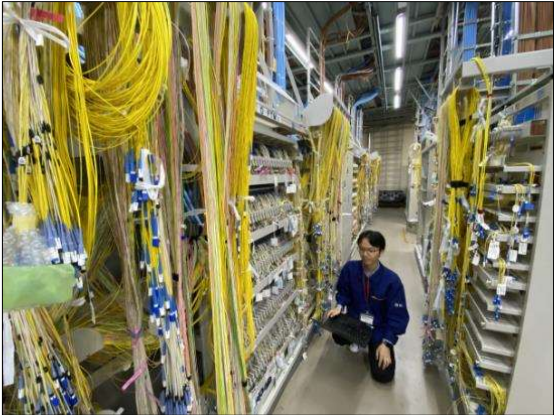
地域の大量の加入光ファイバが 1 箇所の NTT 東日本ビルに全部集まる
