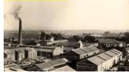
繊維 大和紡績高田工場 (1896年)
