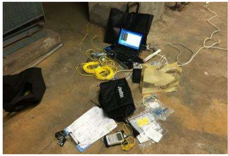
素人 ファイバー 接続工事
